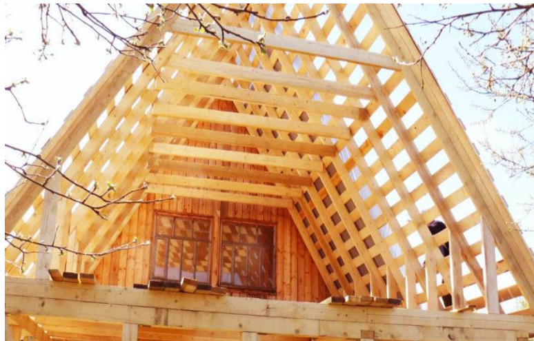
Şəkil 1.3. Dam örtüyünün qurulması
