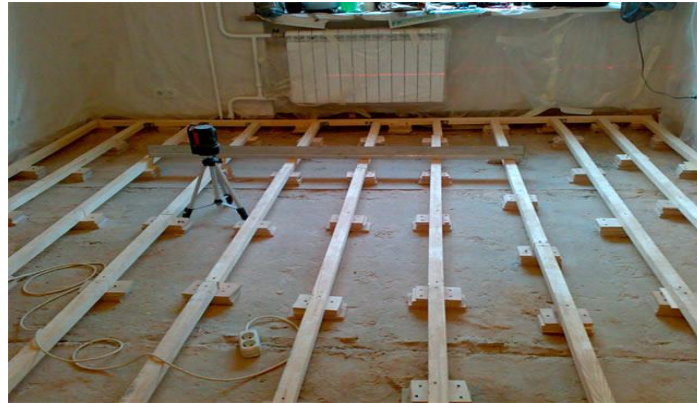
Şəkil 1.6. Taxta döşəmənin döşəmə tirləri üzərinə düzülməsi
