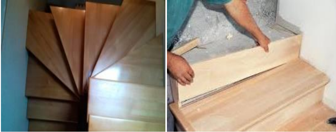
Şəkil 1.10. Tambur və pilləkənlərin quraşdırılması
