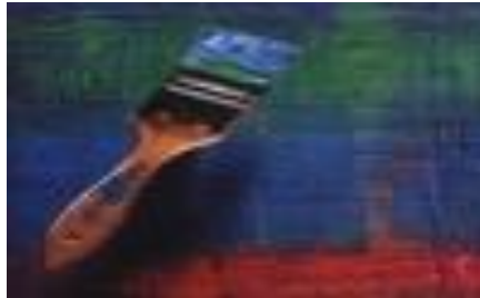
Şəkil 1.20. Antiseptik məhlulun ağac məmulatının üzərinə çəkilməsi
