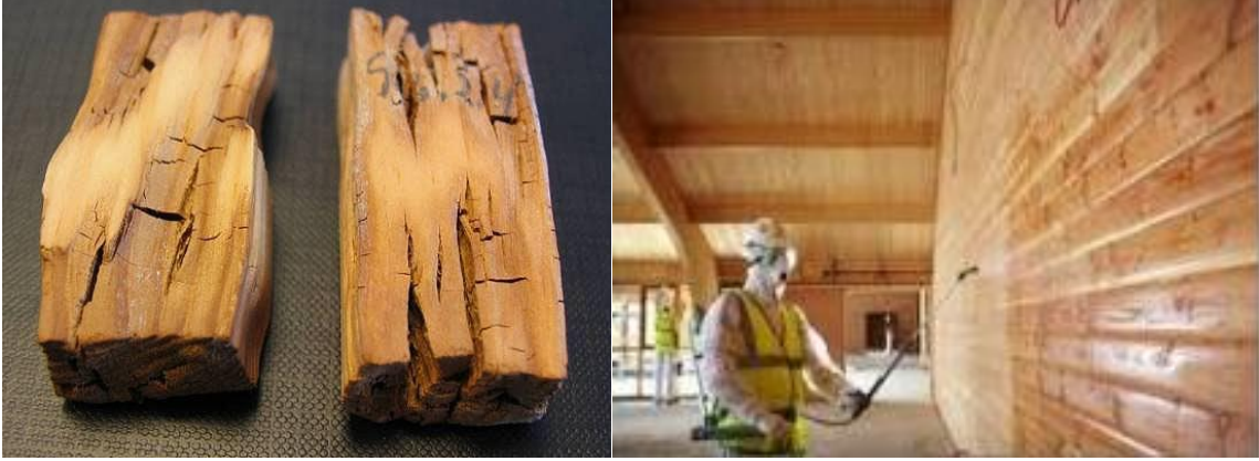
Şəkil 1.35. Ağacın çürüməkdən qorunması
