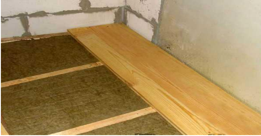
Şəkil 1.7. Ağac materialının döşəmə tirinin üzərinə düzülməsi
